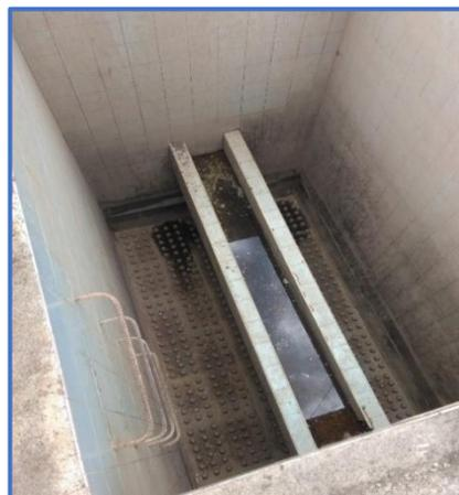
Se realizó el refuerzo al marco que sujeta la lámina del falso fondo a las paredes de filtro. Este marco pasó por un proceso de impermeabilización para una mayor durabilidad. Se realizó este proceso, debido a que dos de los filtros presentaban desgaste en estos bordes, y por estos se perdía material del lecho filtrante, también como dificultaba el retrolavado del mismo.
