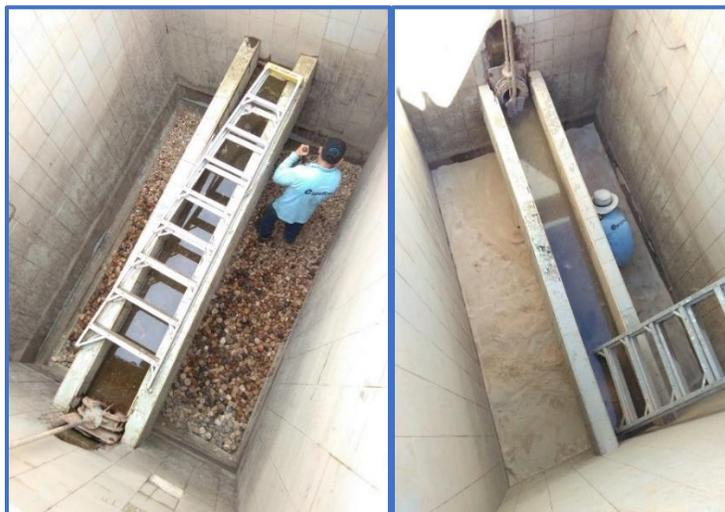
El material filtrante fue repuesto por los operarios y técnicos de la PTAP, agregando uniformemente cada una de las capas del lecho.
