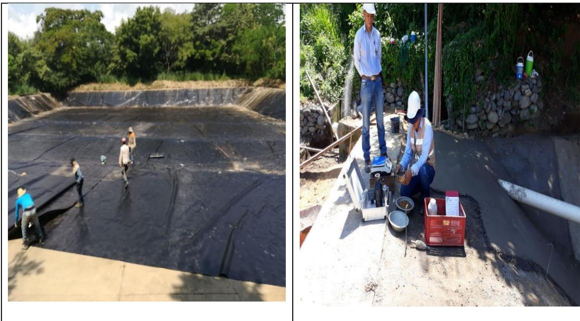
Se espera que la obra sea entregada y tener la laguna en operación en el primer trimestre del 2018. Posterior a las obras que se ejecutaron (Construcción de Gavión, revestido en concreto, conformación de talud en material granular, revestido de mortero, caja de inspección para la conducción del agua residual, e instalación de compuertas metálicas), además se realizaron ensayos de densidades para verificar el grado de compactación de material granular compacto.
