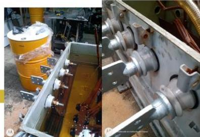
Inyección acetite nuevo, cambio de empaquetadura
