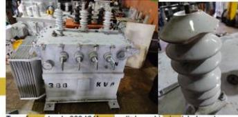
Transformador de 300 KVA, se realizó cambio de aislador roto
