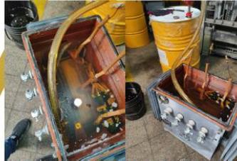
Inyección de aceite nuevo, cambio de empaquetadura nueva y herrajes modernos
