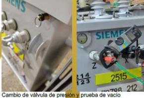
Cambio de válvula de presión y prueba de vacío
